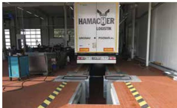
Der Bremsenprüfstand und die Verankerung für die Niederzugvorrichtung mussten gesondert verstärkt werden.
